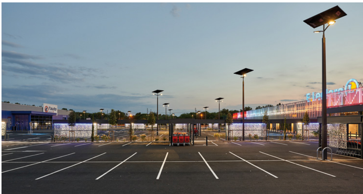
Parking du centre E.LECLERC Carcassonne. Crédit : Fonroche Energie.
